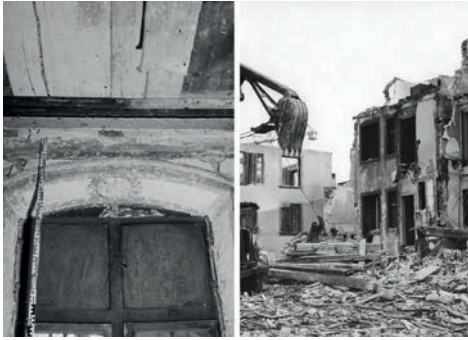
Abb. 1: Basel, ehemals Hebelstrasse 12, links: Wandmalereifragment Inv. Nr. 10073, in situ im Bogen einer Fensternische vor der Abnahme, freigelegt; rechts: Abbruch der Hebelstrasse 12-18. (© Kantonale Denkmalpflege Basel-Stadt, links P. Denfeld 1965, rechts Brönnimann 1966)
