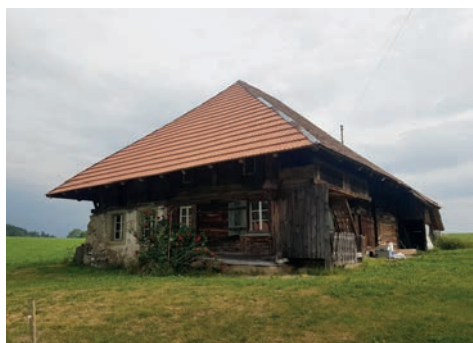
Abb. 1: Bauernhaus an der Kühlewilstrasse 30 in 3086 Wald, Ansicht von Süd-Ost. (Jonas Roters 21.06.2023)
