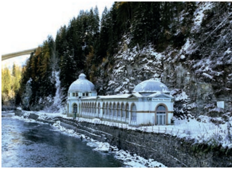
Abb. 1: Büvetta Tarasp, mit Blick auf den Eingang der Westfassade und der zum Fluss hingewandten Nordfassade. (M. Jegge, 2022)
