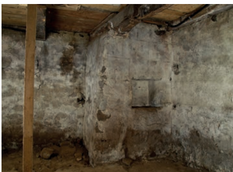
Abb. 2: Raumsicht des Kellers in Richtung Nord-West. (Chris Richter, Anne Zumstein 30.03.2022)
