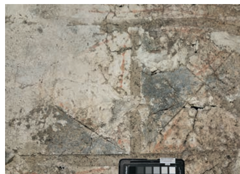
Abb. 3: Detailansicht der in den Wandputz geritzten und farbig gefassten Diamantquaderimitation. (Anne Zumstein 21.04.2022)
