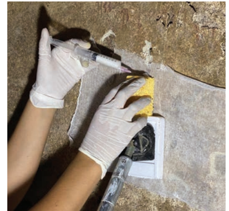
Fig.3: Intervento di grouting per l'adesione di gravi distacchi dell'intonaco precedentemente stabilizzati con velinatura temporanea e puntellatura.
