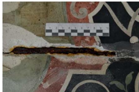
Fig 2: Presenza di elementi metallici all'interno del supporto, lacune dello strato di supporto e degli strati più superficiali, presenza di efflorescenze saline.
