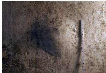
Fig 2: Esempio di distacco tra gli strati componenti il supporto murale, caratterizzato da un'ampia distanza tra le porzioni di intonaco. Oratorio di San Rocco, Ponte Capriasca (TI-CH) (foto da Cavadini et al., 2014).
