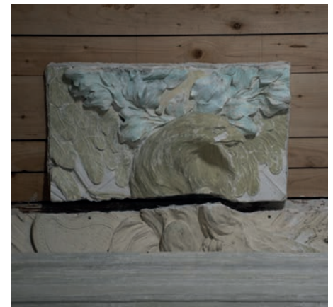
Fig.3: Frammento in stucco raffigurante un'aquila ricollocato sul solaio ligneo della Galleria degli angeli nel Castello di Uherčice.
