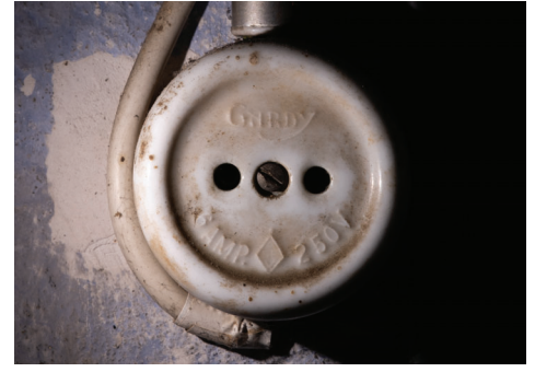
Abb. 3: Zweipolige Aufputzsteckdose aus Porzellan, Marke «Gardy», ca. 1935, Castello Trefogli Torricella/TI (André Lison, 2023)
